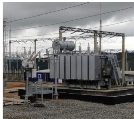
Рис.4. Фото общего вида и выемной части магнитно-вентильного управляемого реактора трансформаторного типа мощностью 25 Мвар напряжением 35 кВ. (РТУ-25000/38,5-УХЛ1).
